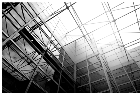
Substitution du verre pour les toitures et barrières anti-bruit
